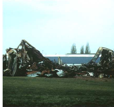
Effondrement d'un hangar en acier
