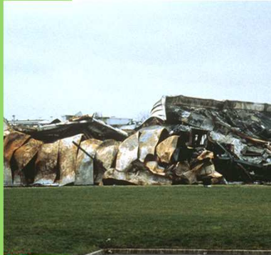
Effondrement d'un hangar en acier
