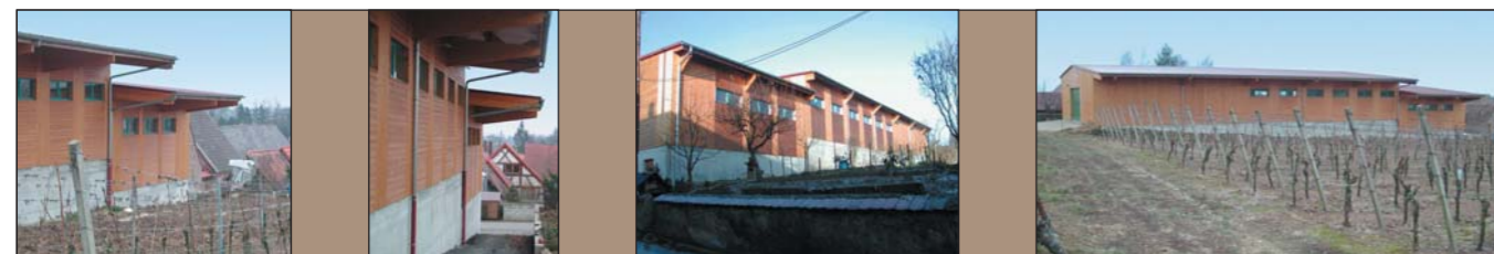
▲ Dégradé sur le village façade Ouest
