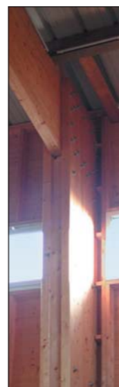
▲ Assemblage poteau/poutre
