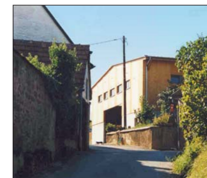
▲ Vue depuis les vignes sur la façade Sud
