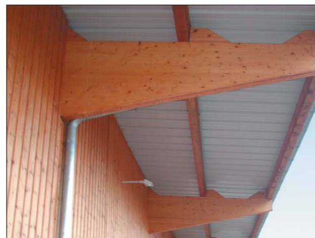
▲ Porte à faux (poutre lamellé collé)
