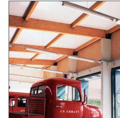
▲ Charpente et façade bois sur garages
