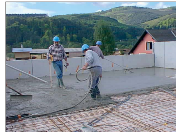
▲ Coulage de la dalle de compression, épaisseur 9 cm
