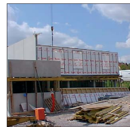
▲ Poutres support du plancher bois-béton
