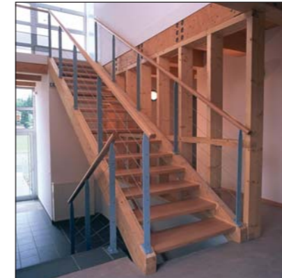
▲ Escalier d'accès à la salle d'instruction
