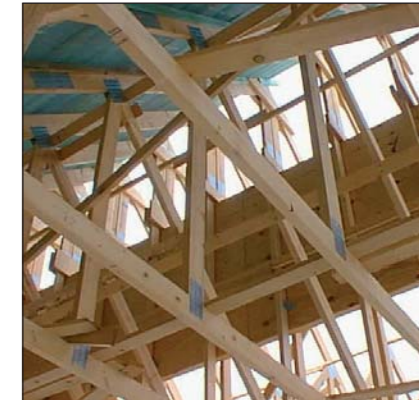
▲ Poutre au vent supportant les fermettes
