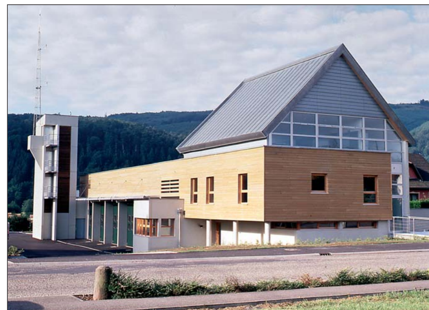
▲ Vue sur angle Nord/Est
