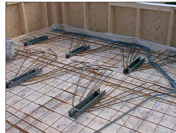
▲ Connecteurs et ferrailage liaisonnant bois et béton
