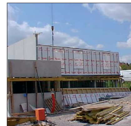
▲ Pose des façades en ossature bois
