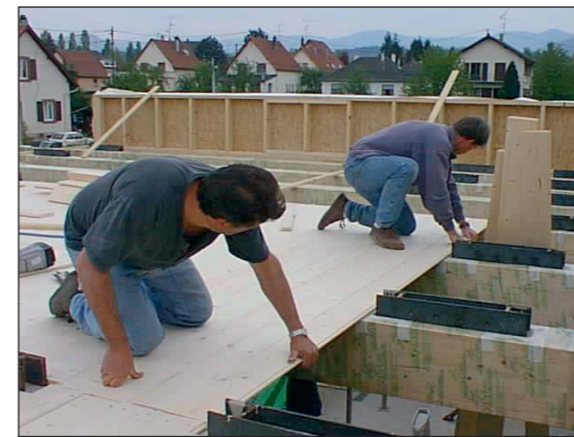
▲ Pose du platelage / coffrage collaborant du plancher bois-béton
