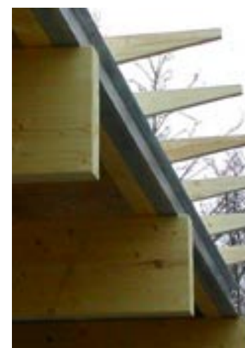
mise en œuvre du débord de toiture
