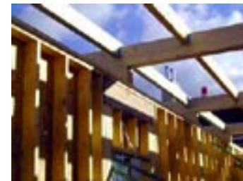
ossature bois / appui sur linteau
