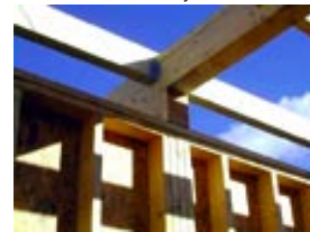
ossature bois / appui sur poteau
